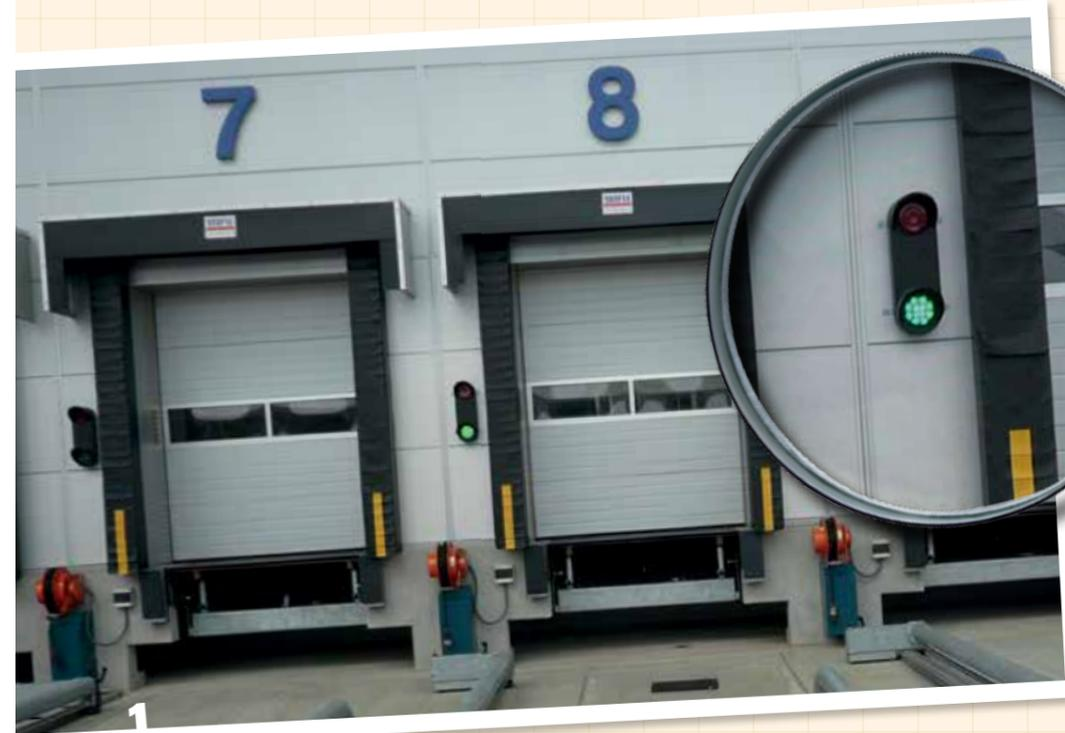
1. La estructura Stertil Combilok guía a los vehículos hasta su posición correcta. Nótese las luces para comunicarse con el conductor.
